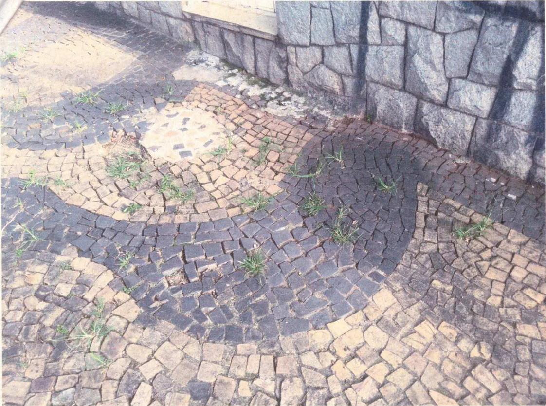
**Calçada em boas condições de acessibilidade, muro íntegro sem trincas**
