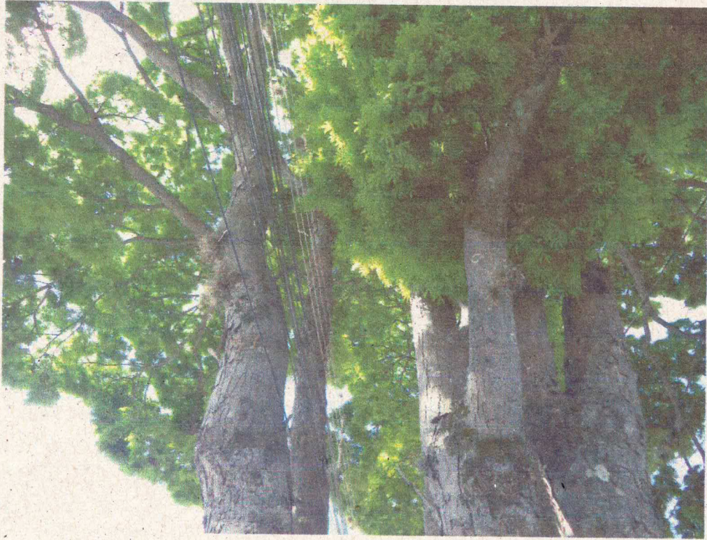
Galhos e ramos em contato com a fiação.
