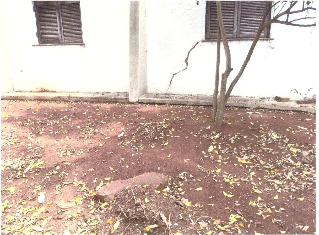
**Trincas na parede da casa causada pelas raízes da figueira que afloraram**
