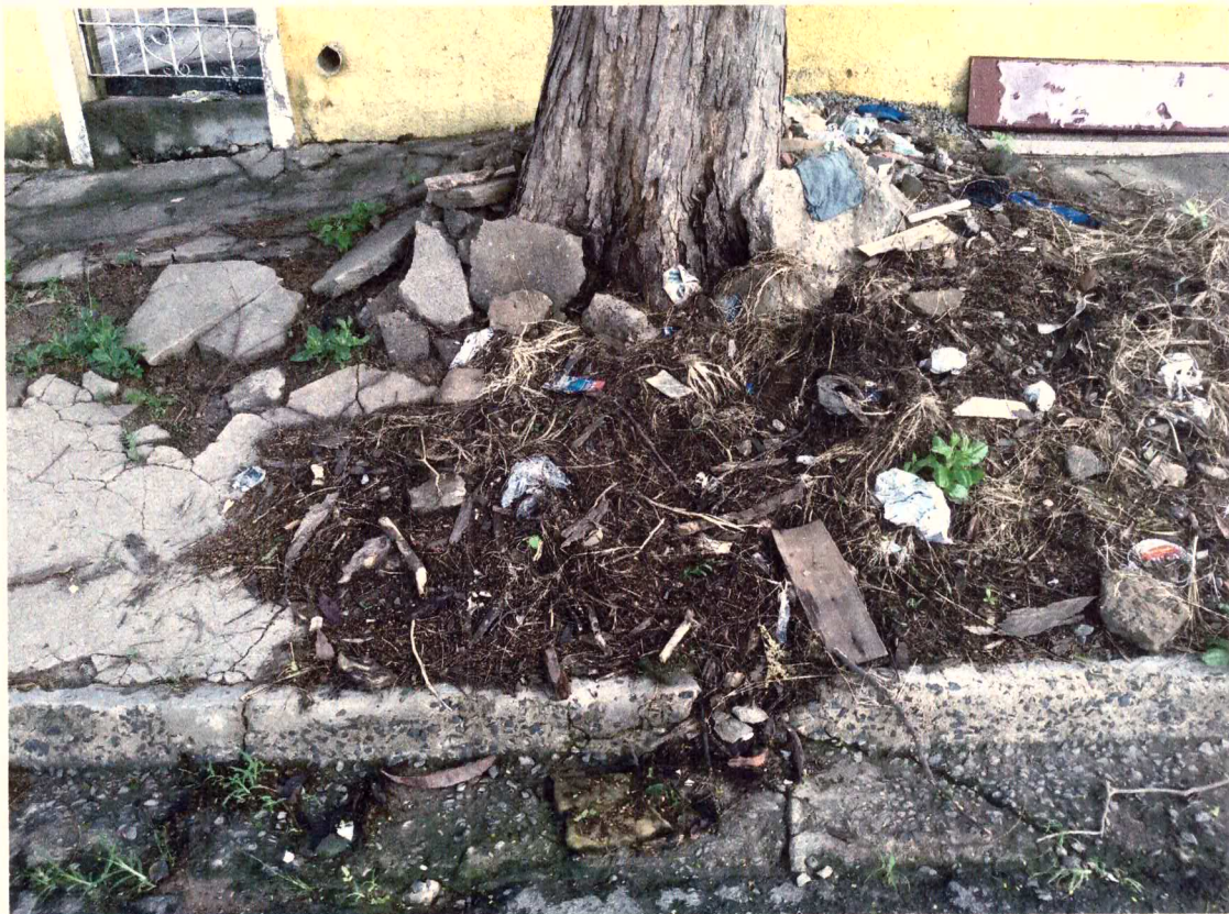
Raízes afloraram e destruíram totalmente o passeio
